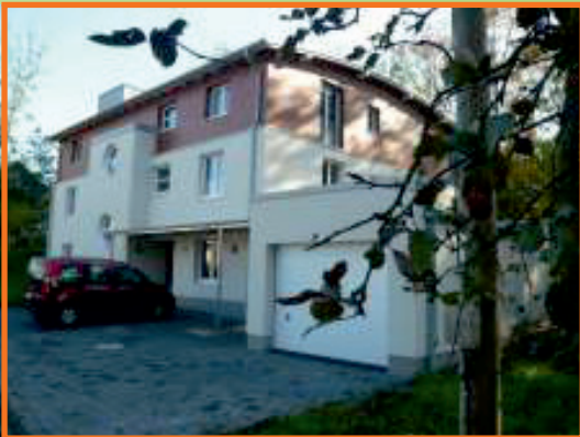
Das Haus „Am Bilten 8“ in Wuppertal mit acht Appartements für Betreutes Wohnen.
